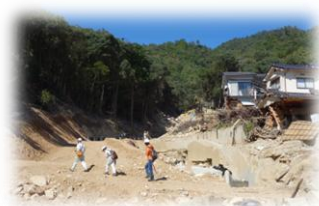
花崗岩 土石流災害 (広島豪雨)
